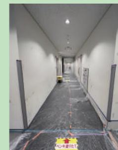
楽屋前廊下の養生撤去作業及び壁面の補修作業
