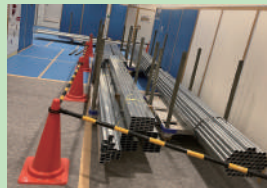
軽量鉄骨と単管
